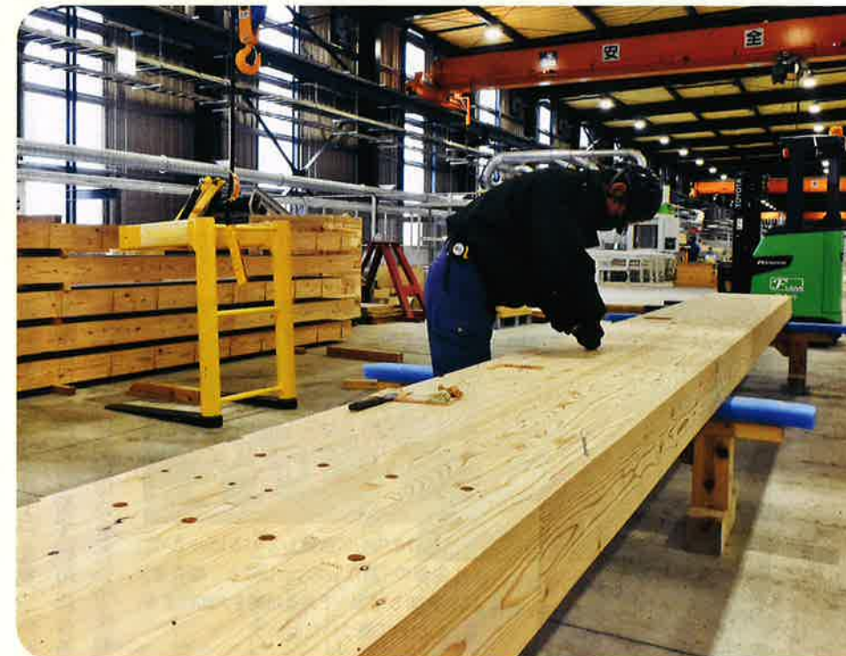
ひときわ存在感を放っていた完成間近の大断面集成材。機械による仕上げが難しい部分は一番最後に人が仕上げる
