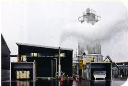
機械乾燥を行うボイラー棟
