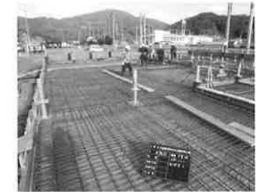
④柱脚金物の現場施工
