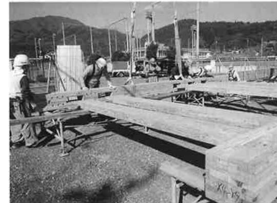
⑤木フレーム地組状況
