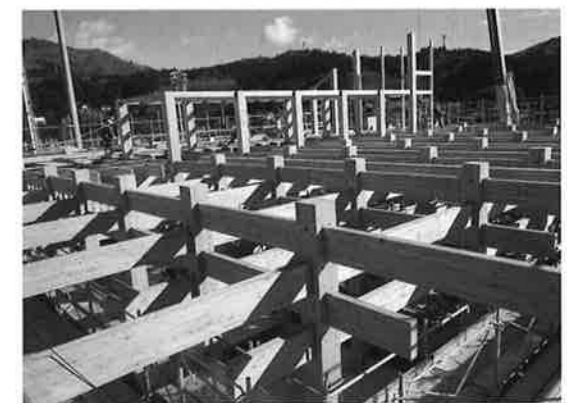
⑩木フレーム組み上がり状況
