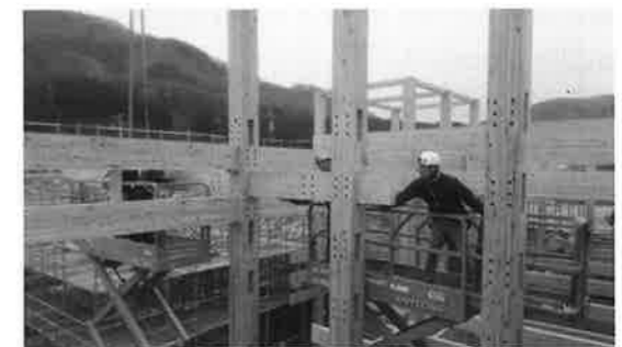
⑧柱へ梁を貫通
