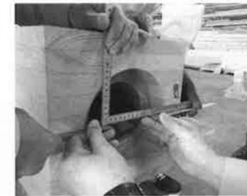
③脚部の削孔寸法確認
