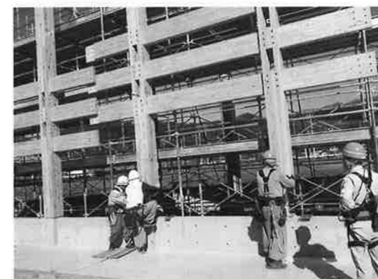
⑦木フレーム建方状況
