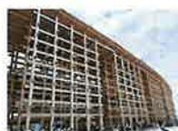
製造に携わった大阪・関西万博の大屋根リング
