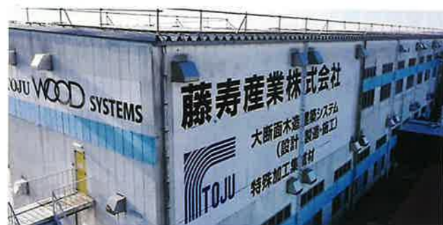
大断面集成材工場（郡山中央工業団地）
