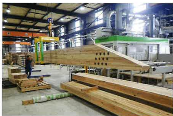
CNC加工機による部材加工
