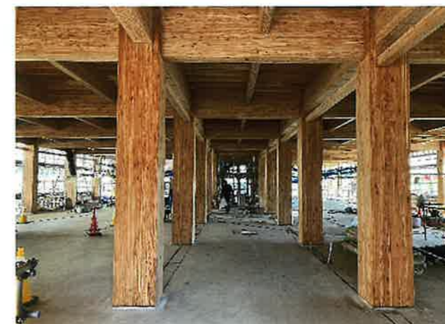
GIR接合による木造ラーメンフレーム
