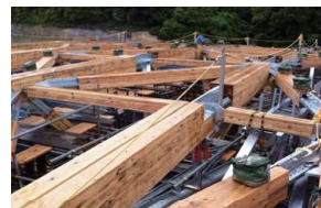
屋根フレーム
