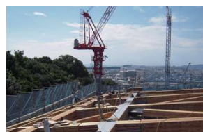
二次部材取付け
