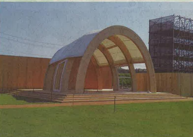
全国植樹祭で天皇・皇后両陛下の御座所となり、会場のシンボルとなる「お野立て所」。県産材を使った構造用集成材を高度な技術で加工して作られた湾曲材のフレームは、温かみのあるやわらかなイメージを醸し出し、県産材の良さを全国にアピールする施設になる=南相馬市原町区疋(しどけ)地区
