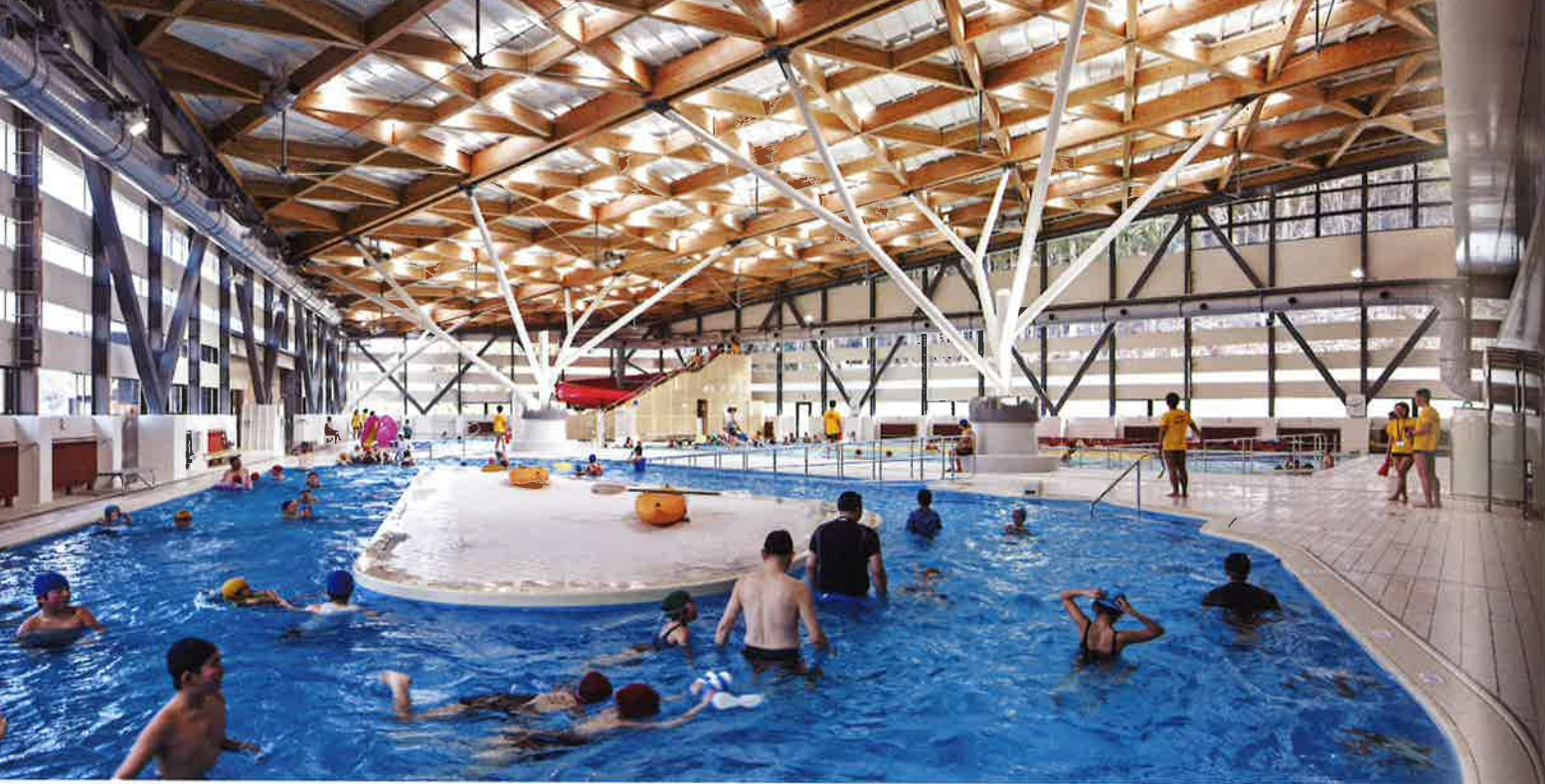
プール 樹形の鉄骨柱が木構造現しの屋根を支える
