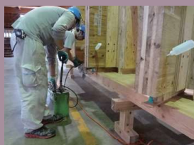
エポキシ接着剤注入状況
